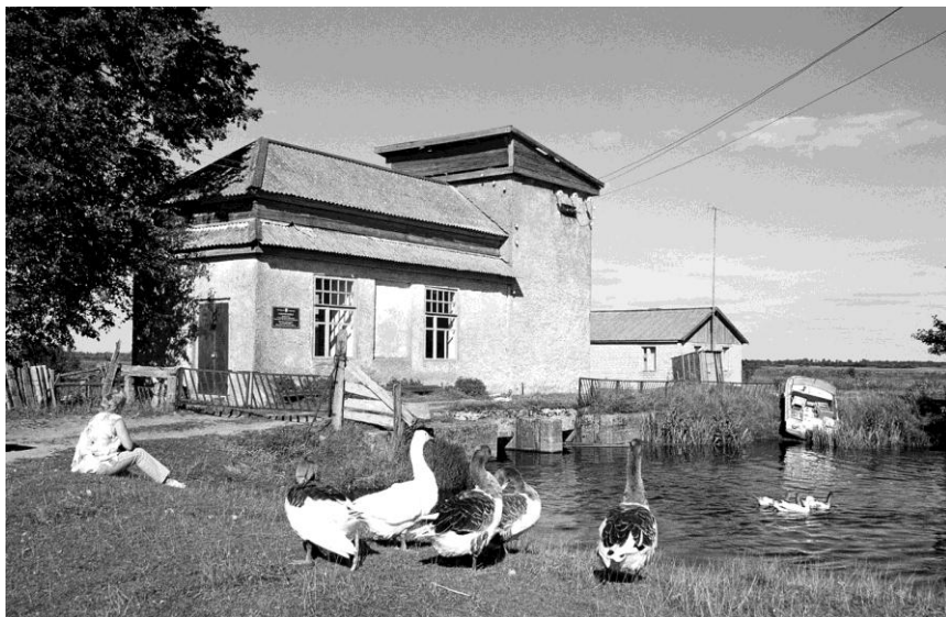
Водонасосная станция на р. Ржевка
